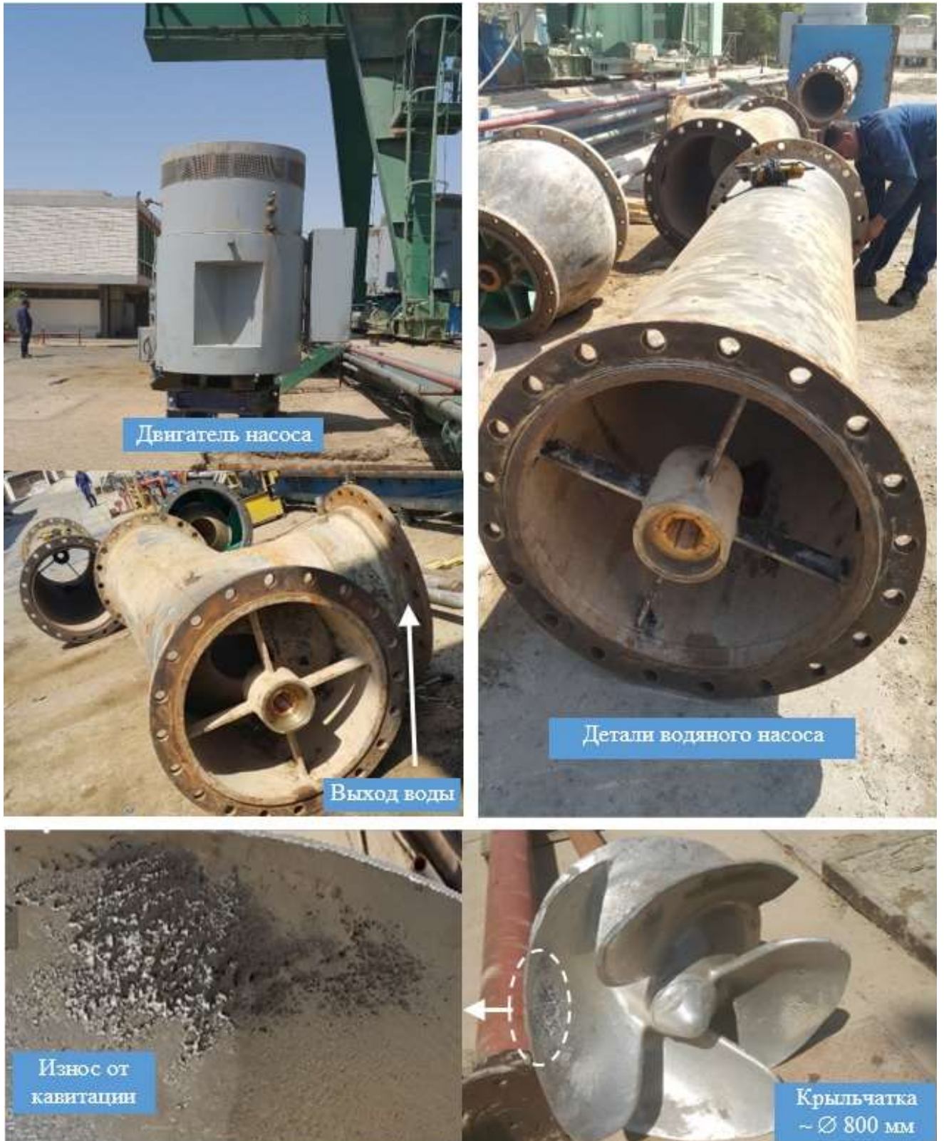
Рисунок 5.1 – Высокопроизводительный водяной насос в период технического обслуживания на электростанции Доры в Багдаде, Ирак
