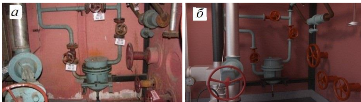
Рисунок 6.20. Использование фотографий (а) для построения виртуальной модели (б) радиационно-опасного помещения РУ БН-600
