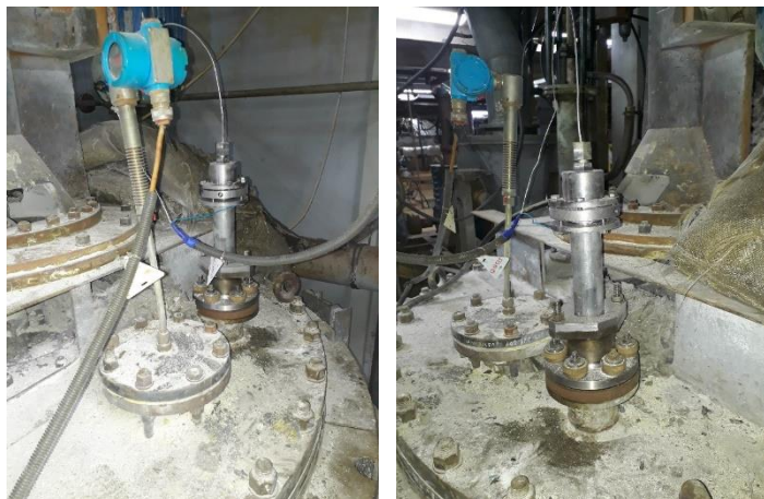
Рисунок 17 – Датчик по определению соотношения основных компонентов расплава KCl-AlCl_3 , установленный в плавитель
