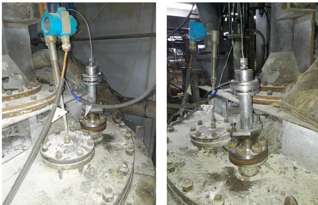
Рисунок 79 – Датчик по определению соотношения основных компонентов расплава  $\text{KCl}-\text{AlCl}_3$ , установленный в плавитель
