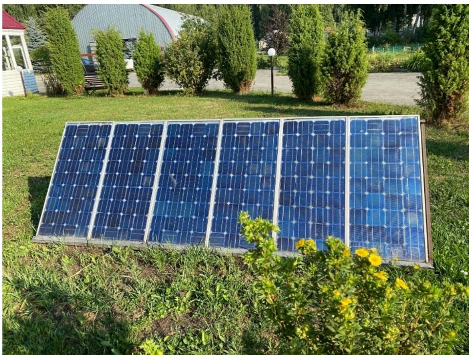
*Рис. 3.8. Фотография ФЭП на основе монокристаллического кремния мощностью 150 Вт*
