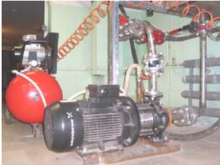
Рисунок П 1.1 Внешний вид насоса NB 32-200/219
