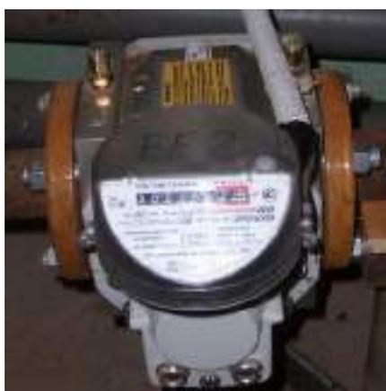
Рисунок П 1.4 Расходомер на воздух Ду 50, RVG G 16 с датчиком импульсов
