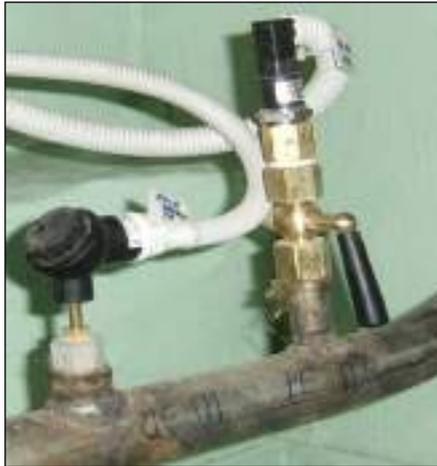
Рисунок П 1.5 Датчик давления (справа) и датчик температуры (слева)
