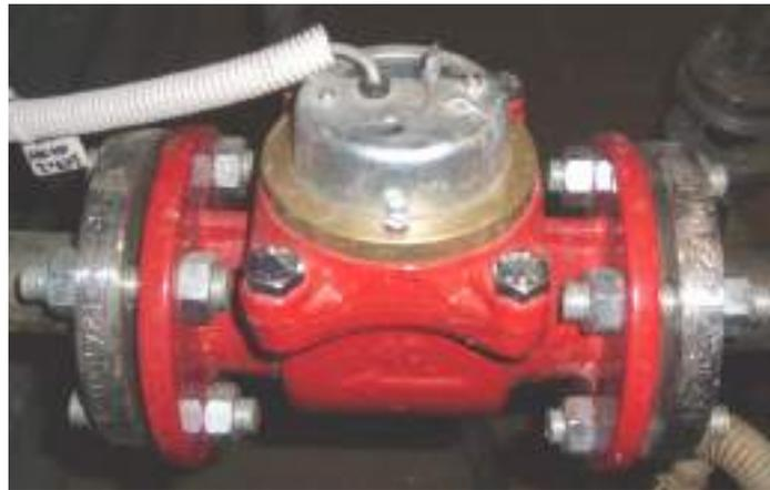
Рисунок П 1.3 Расходомер ВСХН с импульсным выходом
