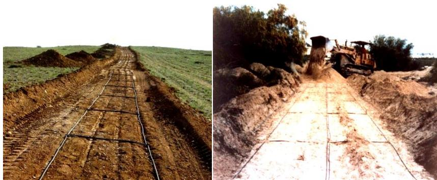
Рисунок 1 — Монтаж двух- и трехлинейных магнитометрических антенн
