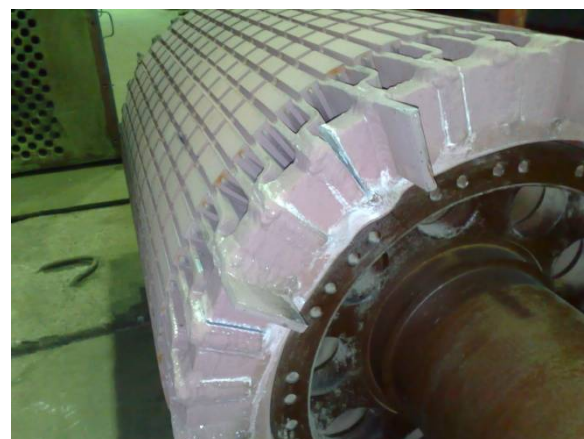
Рисунок 6.2 – Повреждение короткозамыкающего кольца двигателя АДЧР-1600-6.0-4У1
