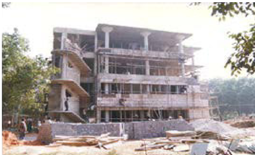
Рисунок Н.5 - Четырехэтажное здание Индийского института технологий Дели, построенное с использованием зольных кирпичей
