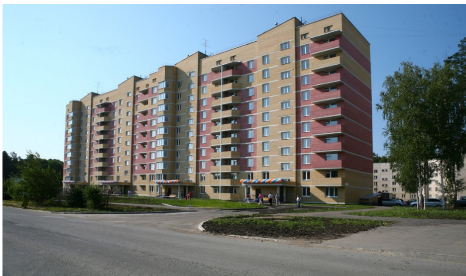
Рисунок Н.21 - Жилой дом в пгт Рефтинский, построенный ООО «ПСО «Теплит»
