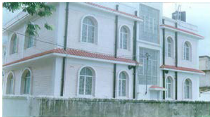
Рисунок Н.6 - Здание, построенное из зольного кирпича в Калькутте, Западная Бенгалия, Индия
