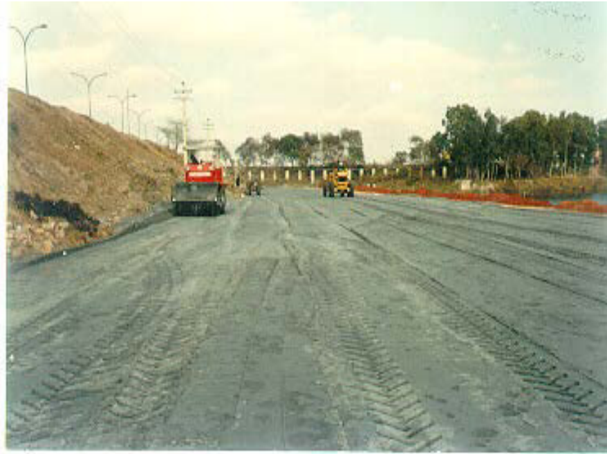
Рисунок Н.25 - Насыпь подъездной дороги к Низамуддинскому мосту в Нью-Дели (в зоне затопления реки Ямуна)
