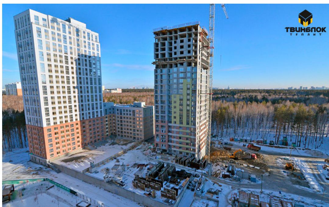
Рисунок Н.22 - 25-этажный дом из Твинблоков в г. Екатеринбург
