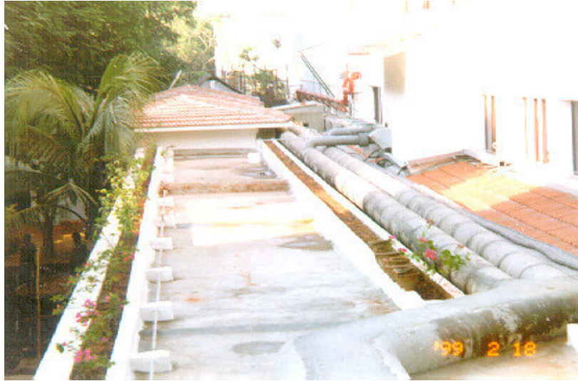
Рисунок Н.7 - Кровельные материалы с использованием летучей золы, Ченнаи, Индия
