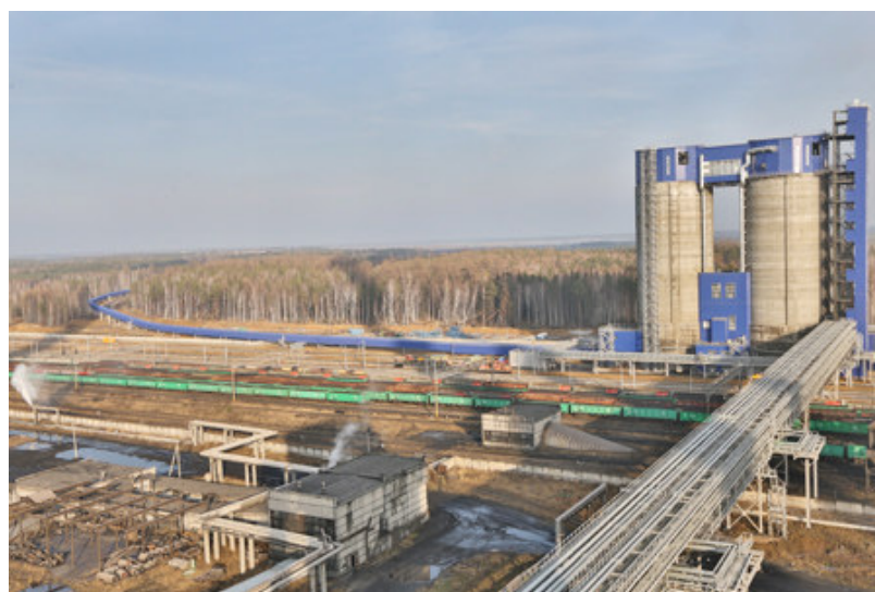
Рисунок 2.15 — Силосный склад системы ЗШУ Рефтинской ГРЭС
