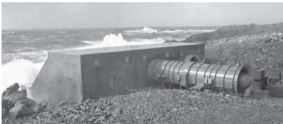
**Рисунок 1.12** Волновая энергетическая установка LIMPET в Шотландии
