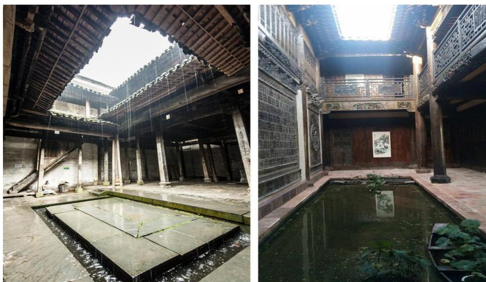
*Рис.74. Два основных типа двора-колодца: слева- с дренажным каналом (фото Нань Фэн); справа- с водоёмом (фото Чжан Имэн).*
