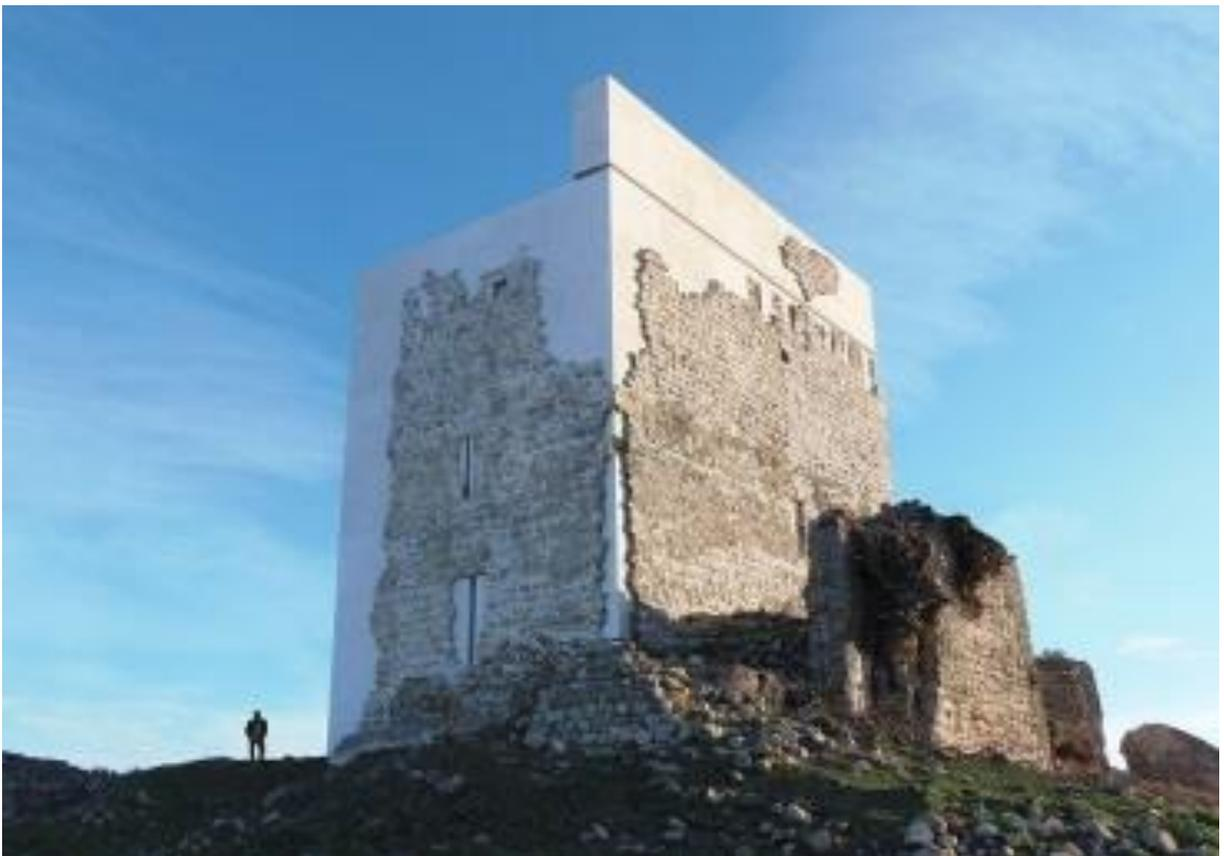
Рис. 70. Укрепление башни замка Матрера, Вильямартин, Испания, 2015 г. Арх. Карлос Кеведо Рохас. Фото до и после реставрации.
