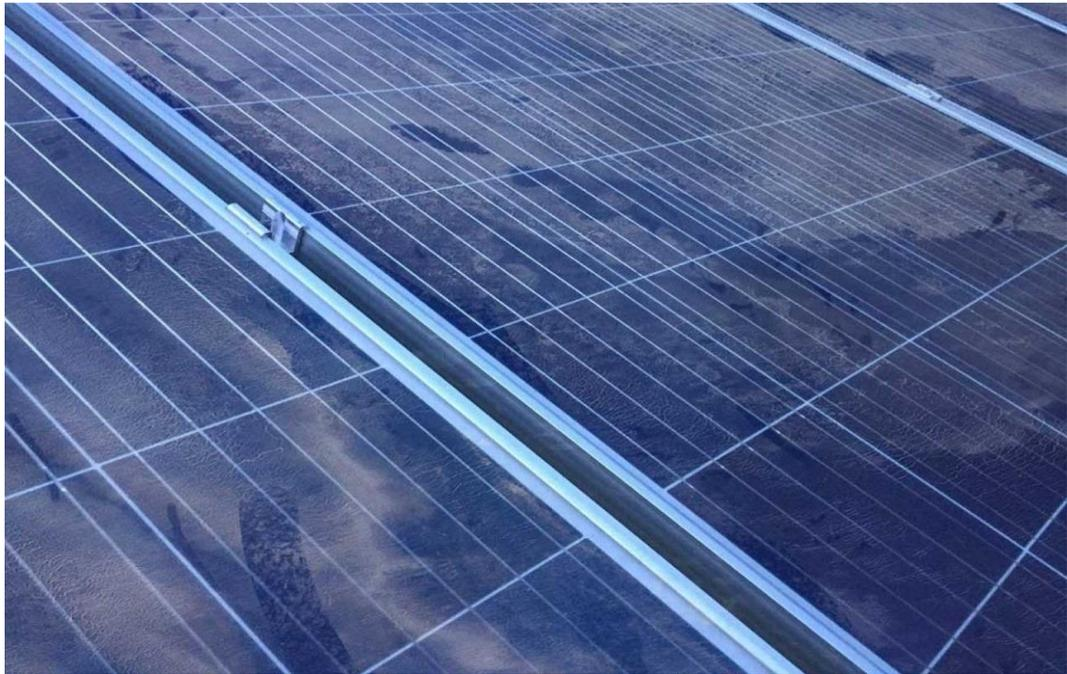
Рисунок 1.6 – Запыленная панель СЭС
