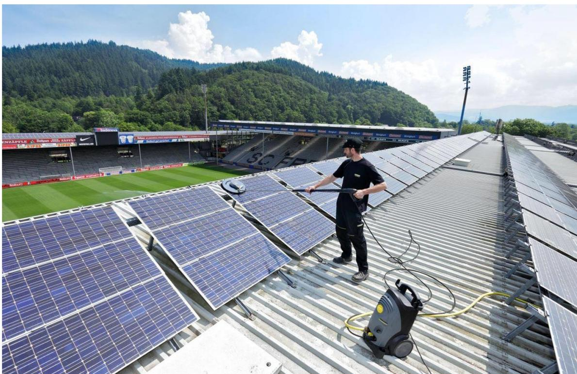
Рисунок 1.8 – Фотоотчет по очистке солнечных панелей на стадионе Фрайбурге
